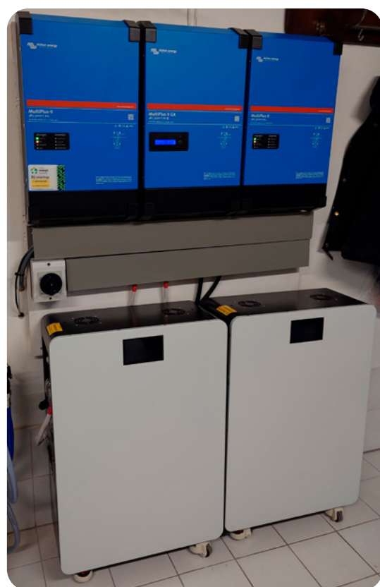
Figuur 3 - Woonhuis voorzien van een 3-fase installatie met 30kWh
